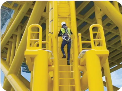
▲ 圖3：勞動檢查員由運輸船（CTV）轉移至海上變電站，須攀登高度20公尺之垂直爬梯
