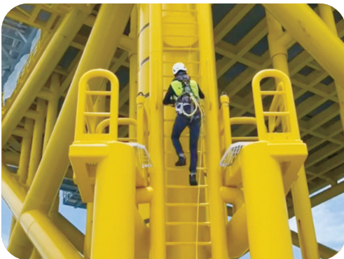
▲ 圖3：勞動檢查員由運輸船（CTV）轉移至海上變電站，須攀登高度20公尺之垂直爬梯
